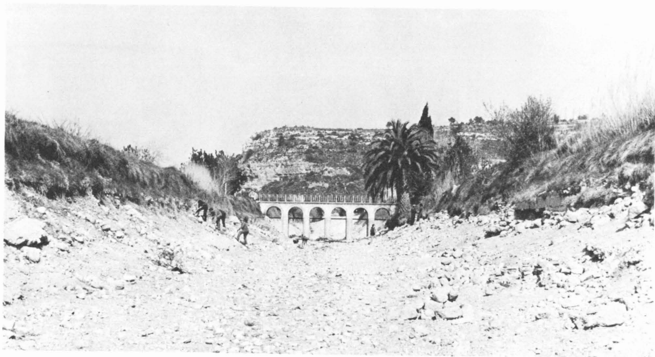
Barrugat. Vista general. Abans d'iniciar les excavacions.
