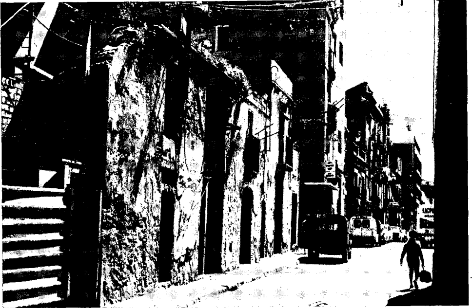
Foto 1: La degradación de las viviendas de Hostafrancs, dada la temprana época de construcción y la pobreza de materiales utilizados, ofrece claras perspectivas a la renovación.
