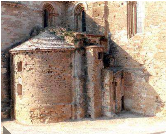
Fig. 1. Vista de l'estructura adossada al mur oest de la sagristia i de la capella gòtica dels Gralla.
