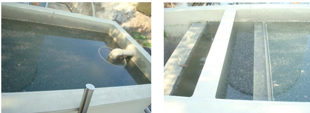
Figura 5.3.1.9.1. Separador de greixos TR.FS1.
