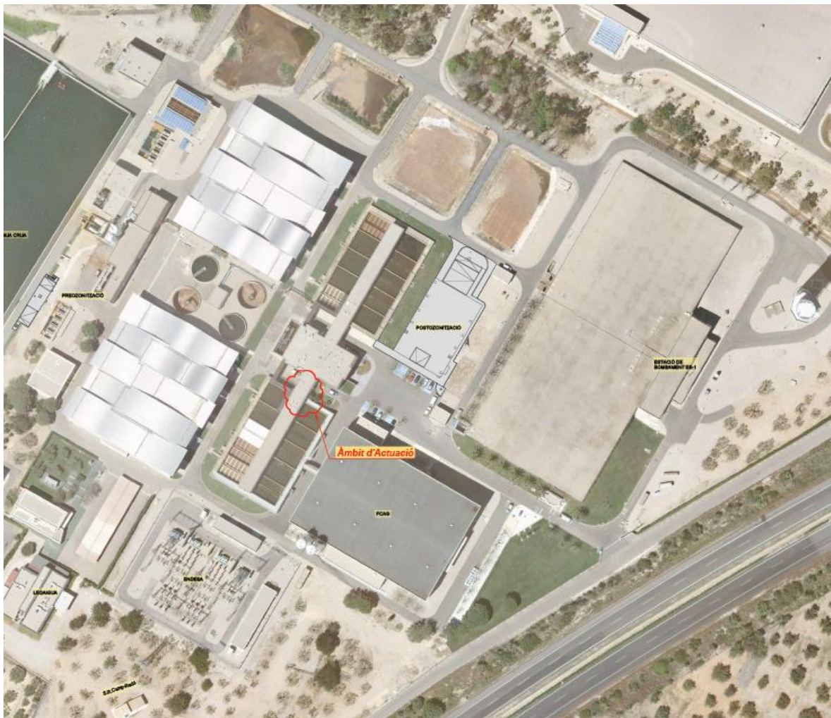
Il·lustració 39 Localització de les instal·lacions dels servidors
