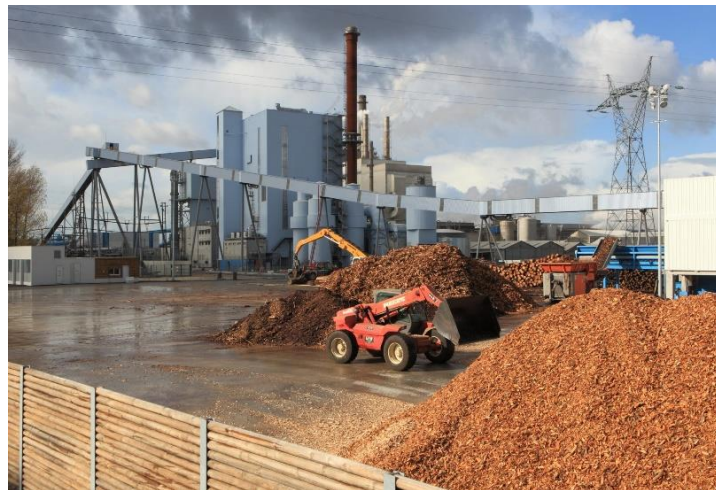
Figura 7. Planta de biomasa.
