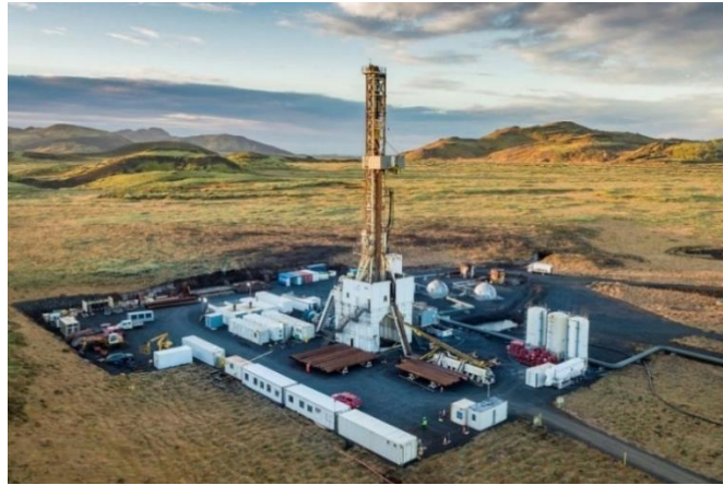
Figura 8. Central geotérmica de alta temperatura.
