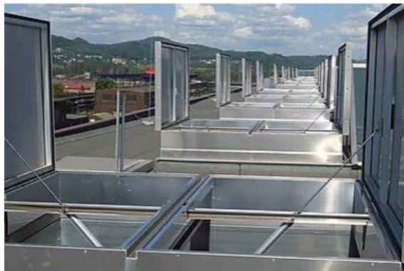
Imatge 3.1.1.2.1. Exutori tipus finestra de doble comporta[5]
