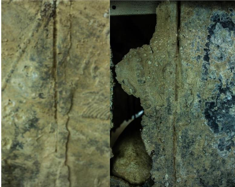
**Figura 5. Detalle de las juntas en el centro de los lados cortos. Imagen: elaboración propia.**
