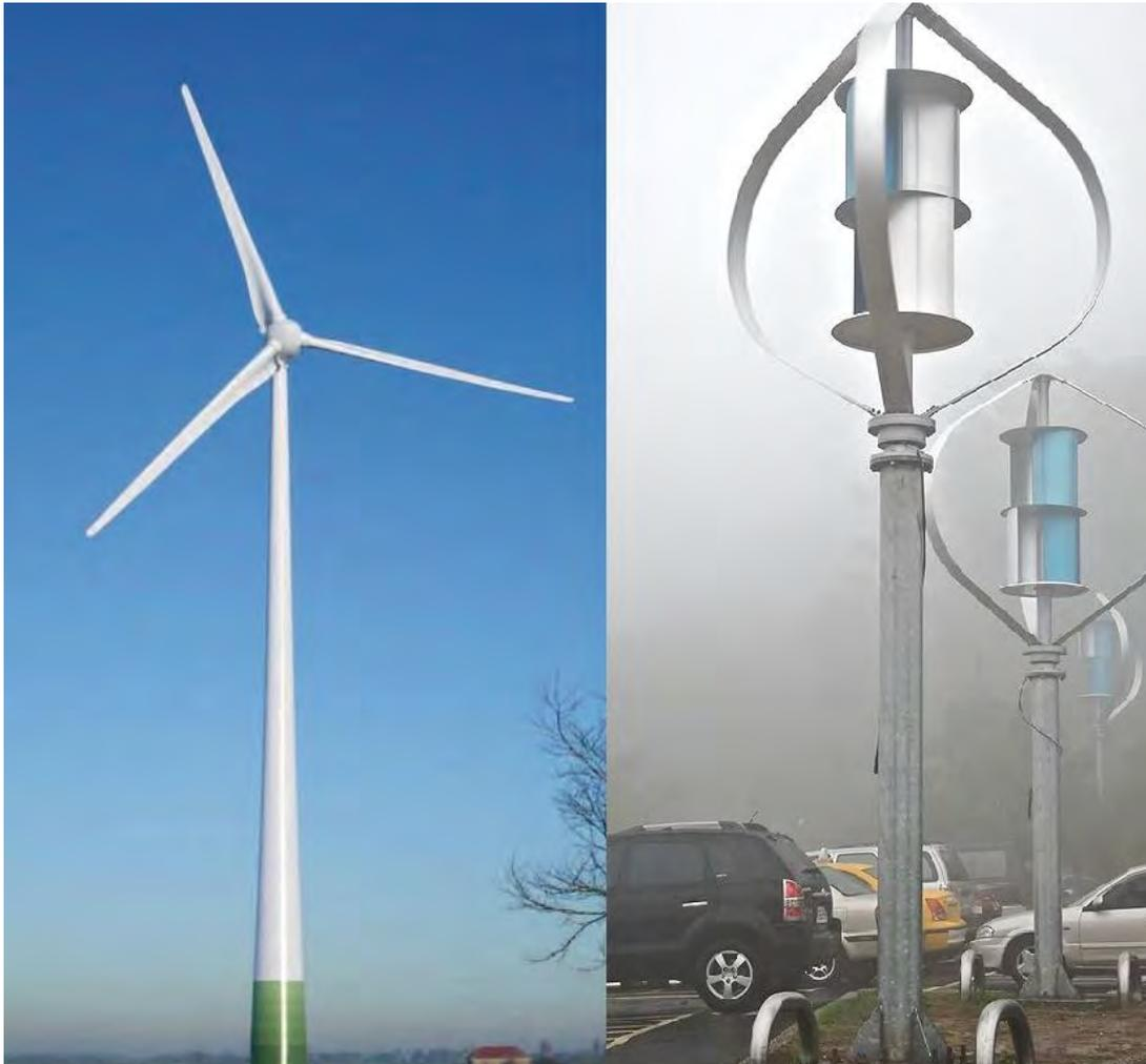
Figura 10. Ejemplo HAWT a la izquierda, ejemplo de VAWT a la derecha <sup>[29]</sup>.
