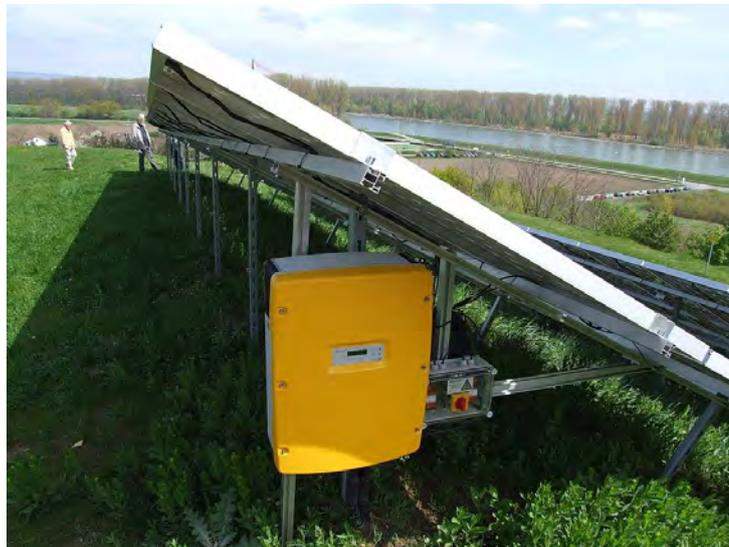
Figura 6. Inversor instalado en un panel solar fotovoltaico <sup>[29]</sup>.
