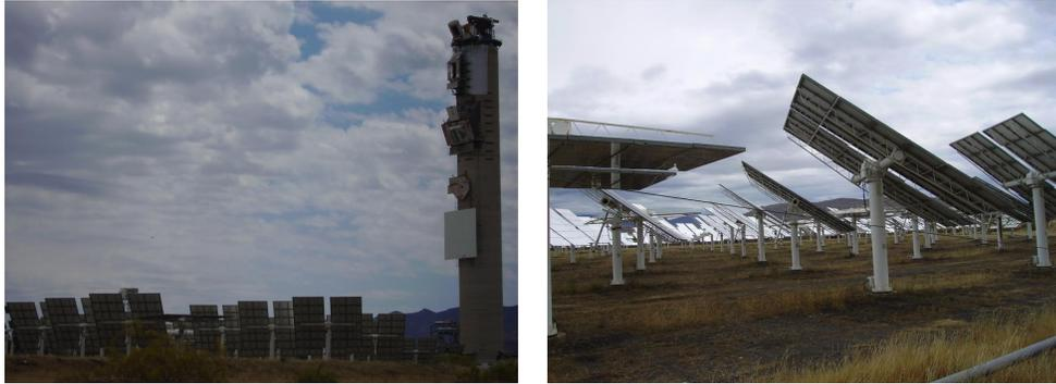
*Figura 3. Receptor solar de torre y campo de heliostatos. Instalaciones de la Plataforma Solar de Almería (PSA), perteneciente al CIEMAT*
