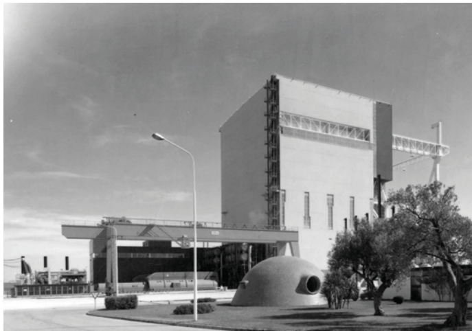
[Fig. 9] Pabellón telefónico, puente grúa y reactor (1972).
