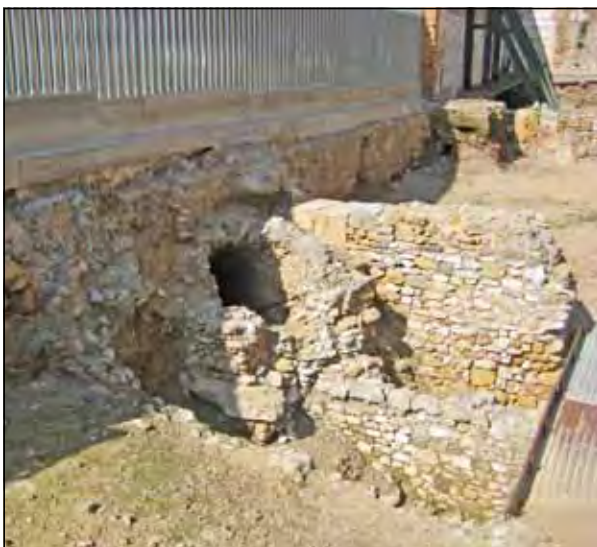
445.- Cloaca abovedada en opus caementicium que desaguaba el parascaenium occidental del teatro.
