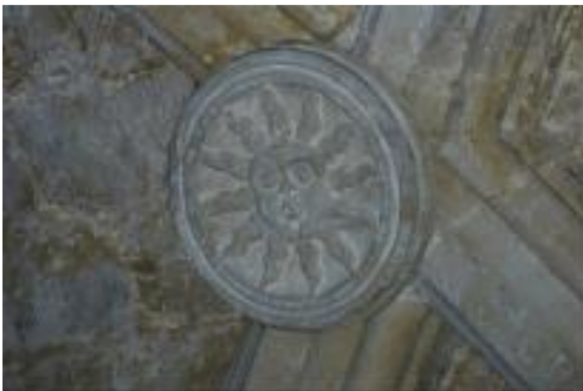
Fig. 10 Sol antropomòrfic. Detall d'arc de volta a l'interior de l'església.
