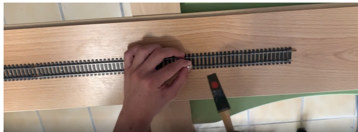
Fotografia 11: col·locació dels carrils a la fusta (font pròpia)
