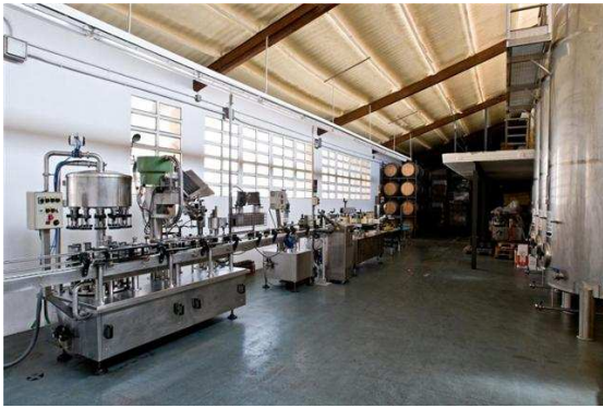
Fig.15 Màquina d'embotellar amb làser
