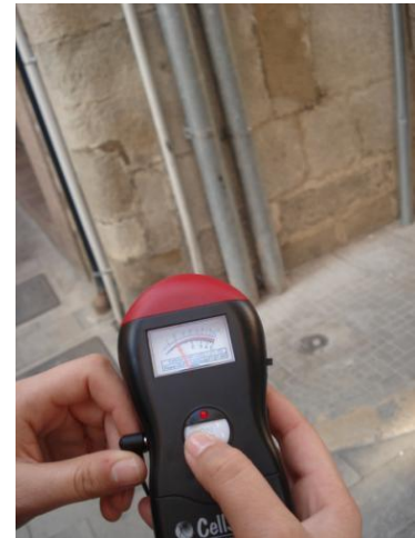
Figura 9- Presa de corrent al Carrer del Carme.
