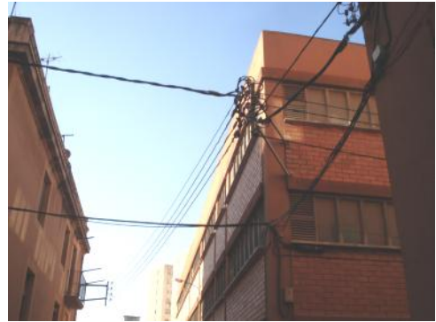
Figura 7- Carrer de la Fortuna.
