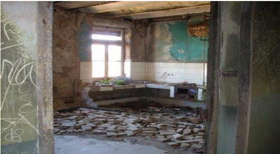
Imatge de l'interior de La Savinosa.
