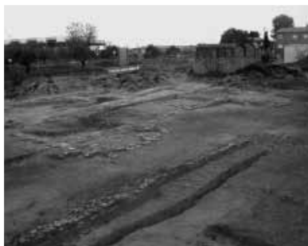
FIGURA 5. Detall del recinte superior del castellum , amb el mur perimetral defensat per torres en primer terme.
