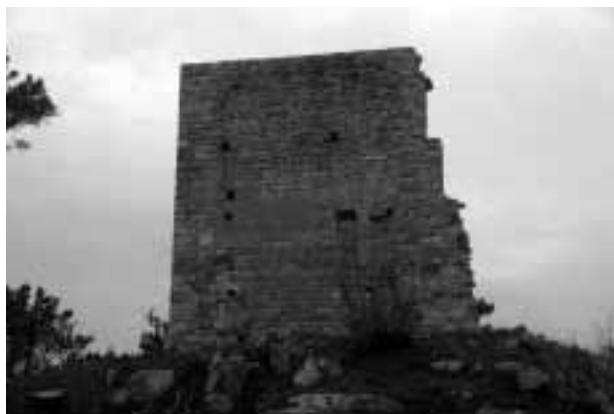
FIGURA 7. Torre bastida amb encofrat de tabiya , hisn de l'Albiol (Baix Camp).
