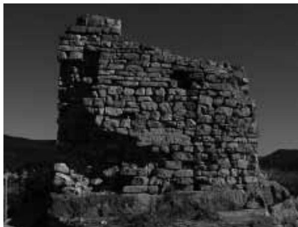
FIGURA 5. Torre bastida amb encofrat de tabiya , hisn de Xibrana (Siurana, Cornudella de Montsant).
