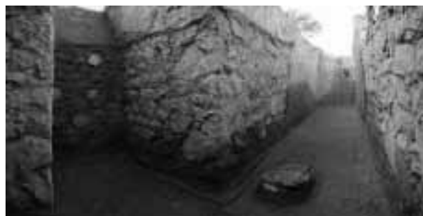
FIGURA 7. Vista interior de la cisterna de la terrassa superior.
