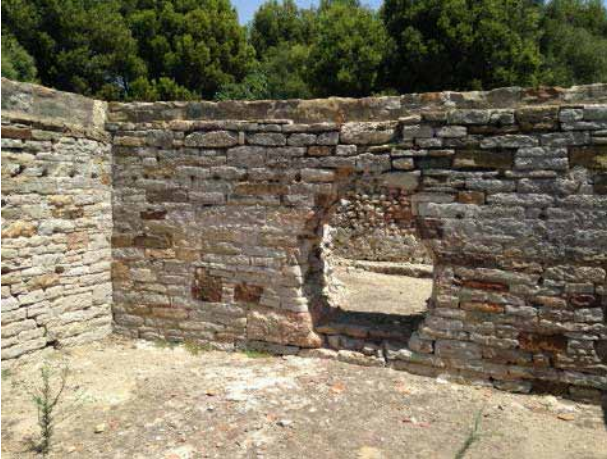
Figura 13. Termas de Carteia . Detalle del muro del caldarium en opus vittatum . © Proyecto I+D+i de HAR2012-36963-C05-01 (2014).
