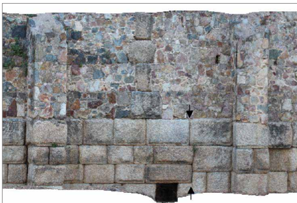
Figura 12. Punto di cesura fra i due diversi settori del Dique.
