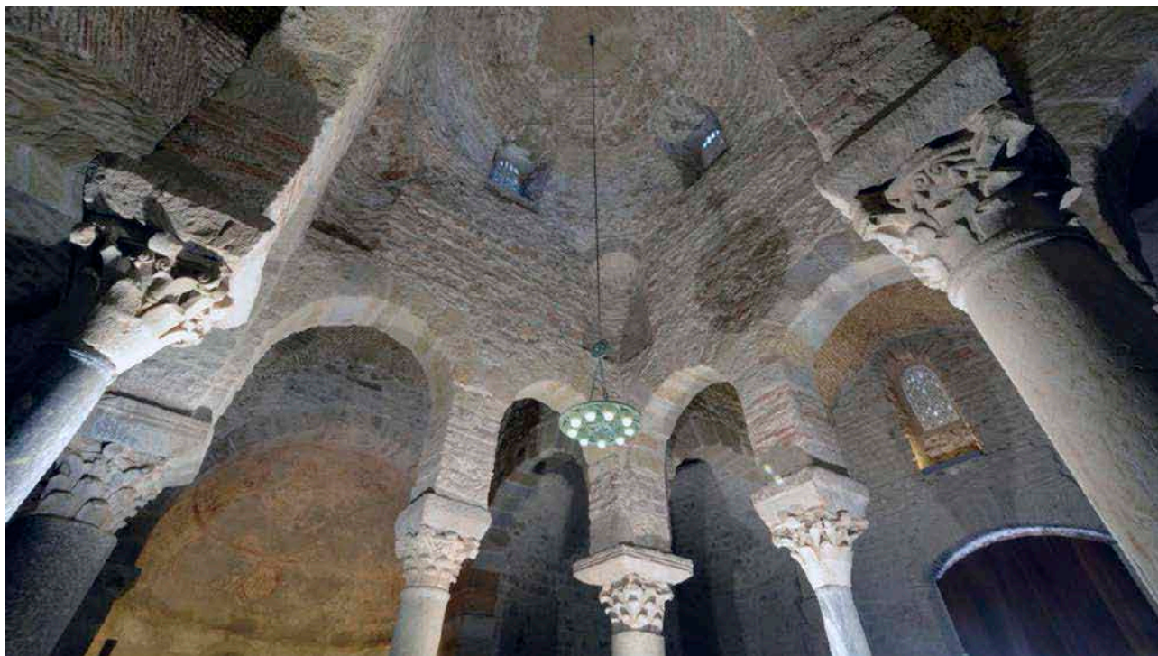
Figura 12. Detalle de los elementos de soporte de la cúpula central (Archivo ICAC - J. M. Macias).
