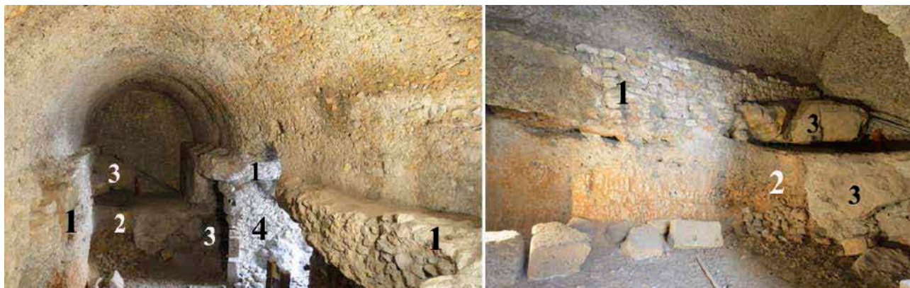
Figura 19. Vistas del sector 3. 1) estribos de la bóveda; 2) margas geológicas alteradas en época contemporánea; 3) bloques megalíticos; 4) plataforma de mortero de soporte de la gradería.
