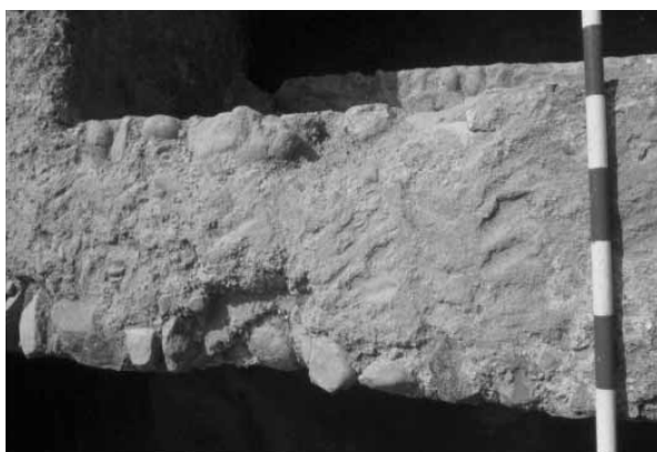
Figura 118. Detall de l'acabat del mur de càrrega nord (UE 1023/A) entre els àmbits 5 i 8. S'observa l'acabat de la cresta del sòcol amb una capa de morter de calç en la qual es veuen fins i tot uns tocs de paleta disposats en espina de peix, que facilitaven l'adherència del cos superior de tàpia.
