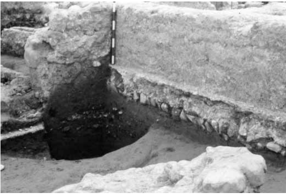
Figura 115. Fonamentació a sacco del límit septentrional de l'edifici de la fase 7 (mur 1023a cara nord).
