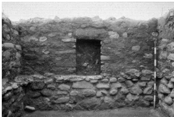
Figura 8. Vista frontal del mur 1005 amb l'obertura 1015, un cop extret el paviment 1045.
