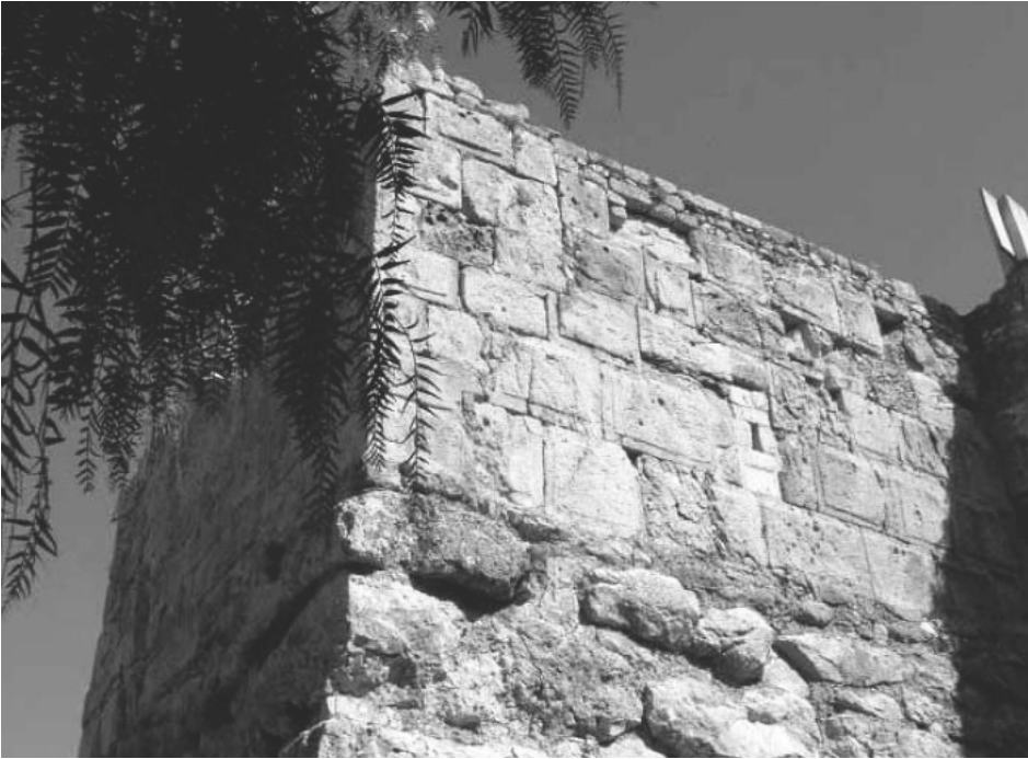
FIGURA 155. Fotografia de la Torre de Minerva amb la vista exterior del mur de l'espitllera.
