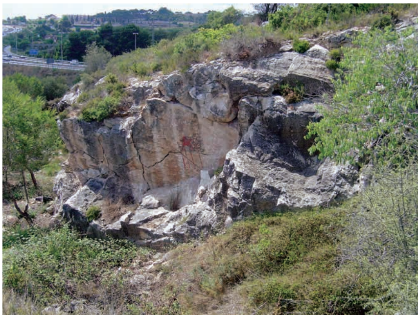
Figura 40. Vista de la part central de la pedrera de la Salut, on es conserva l'única paret regular de tot el front.
