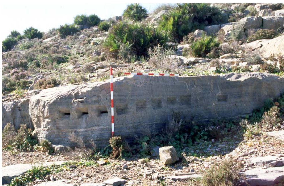
Figura 8. Canteras de caliza micrítica del Cabezo Mingote (Los Nietos, Cartagena). Serie de cavidades para la colocación de cuñas. Fuente: J. A. Antolinos.
