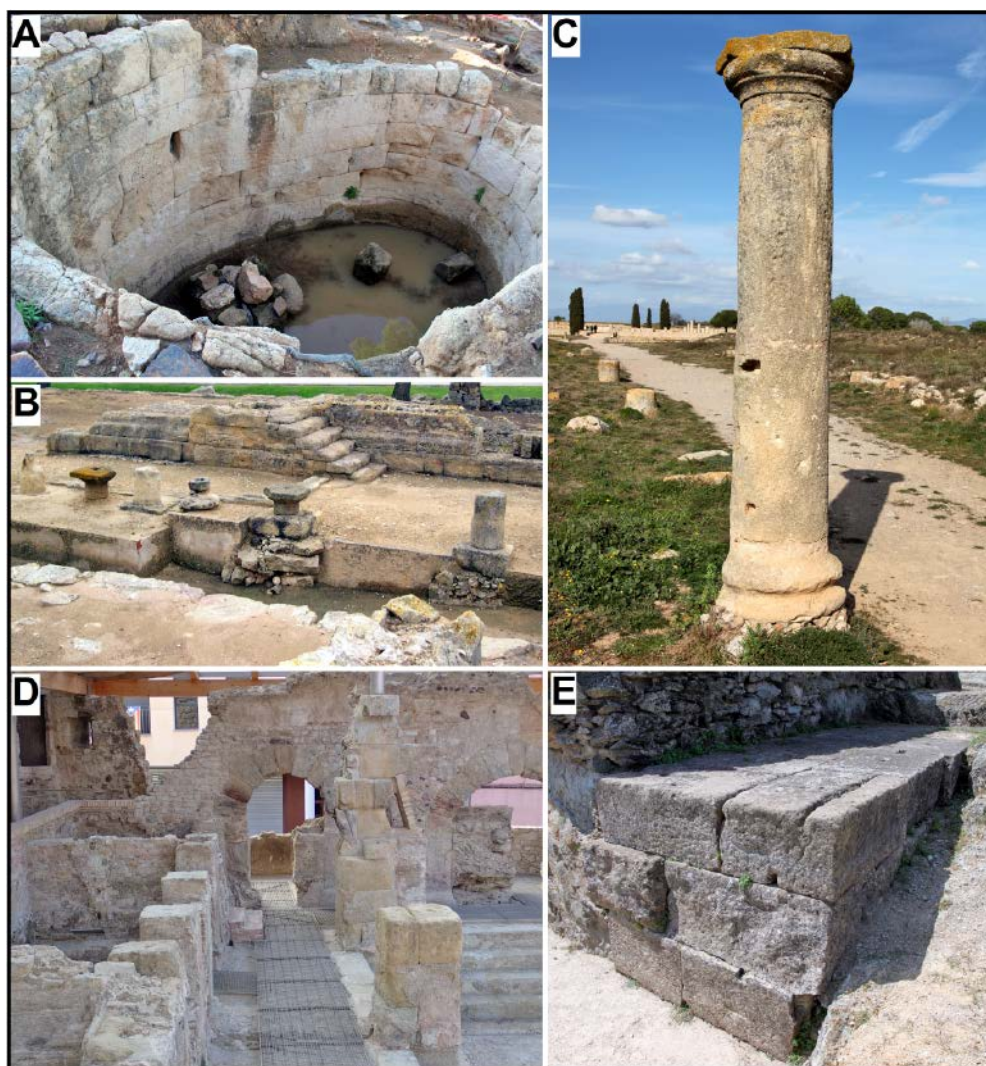
Figura 8. Ejemplos de uso de rocas de la Fm. Folgueroles como material de construcción. A, bloques de revestimiento de una cisterna del poblado ibérico de Castell de Palamós (ca. s. III a. C.). Algunos de los bloques son de conglomerado. B, Santuario de Serapis (Empúries) (s. I a. C.). C, columna del pórtico del cardo maximus (Empúries) (s. I a. C. - I d. C.). D, termas de Aqua Calidae (Caldes de Malavella) (s. I d. C.). Aquí los materiales de la Formación Folgueroles aparecen mezclados con bloques de areniscas y conglomerados procedentes de las canteras romanas del Puig de les Moleres, situadas al este de la ciudad. E, bloques de la base de los trofeos de Pompeyo (Le Phertus) (71 a. C.).
