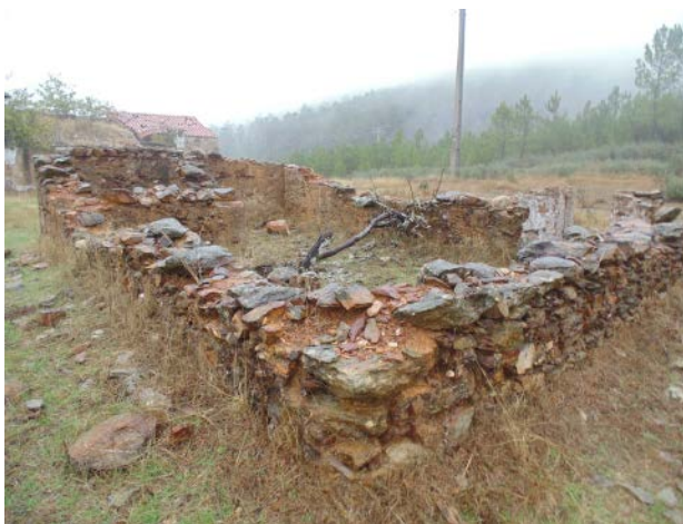
FIGURA 3. Estrutura não identificada junto à ermida, possivelmente associada à criação de gado.
