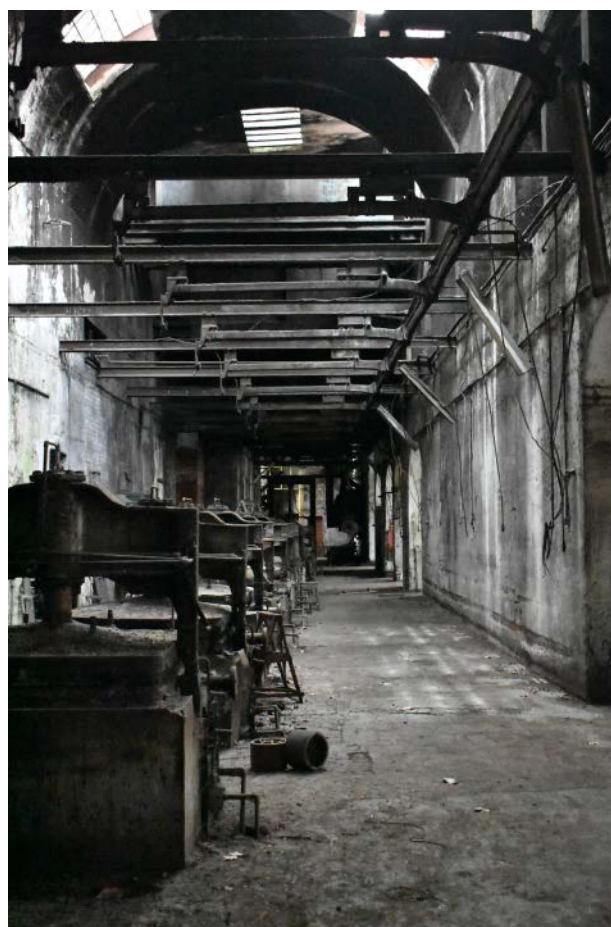
FIGURA 1. Sala das autoclaves da Fábrica Robinson. Exemplo de espólio móvel e arquitectónico.
