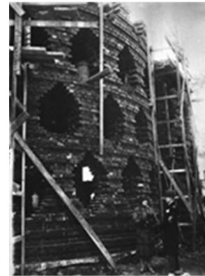
Construcción de la casa en Krivoarbat , 1927.
