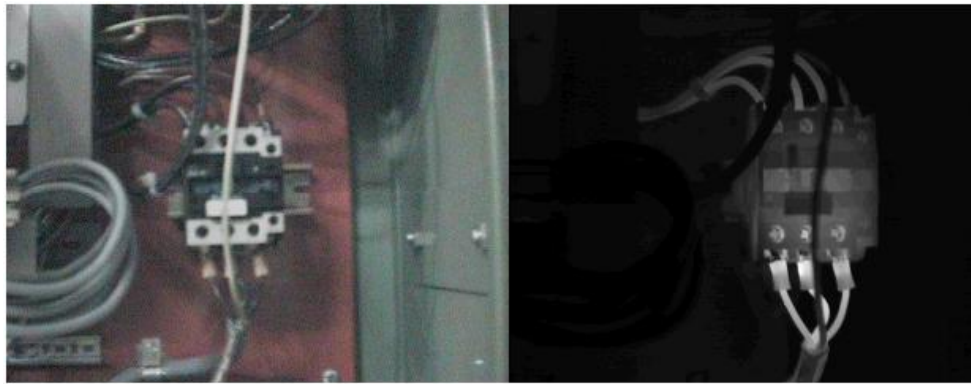
Figura 56. Imagen termografica de prueba .
