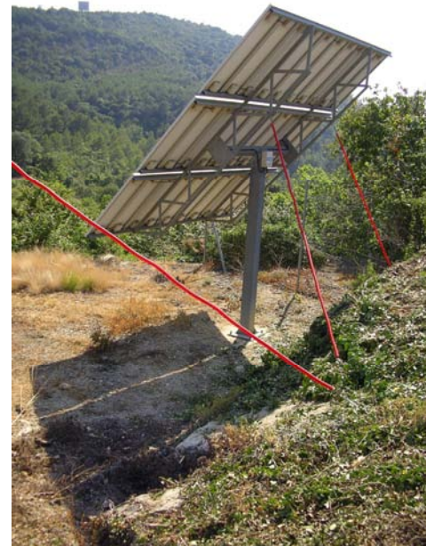
Fotografia 3.12. Detall fixació vents
