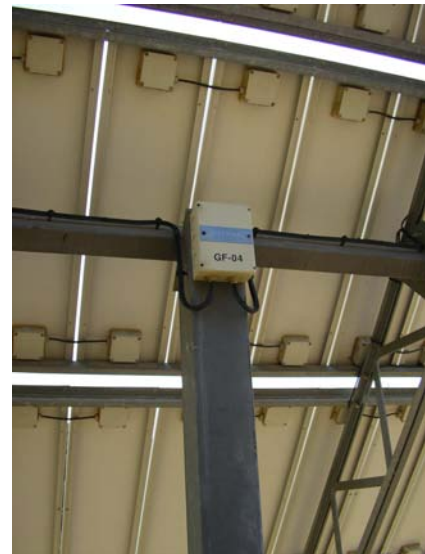
Fotografia 3.4. Detall connexionat mòduls
