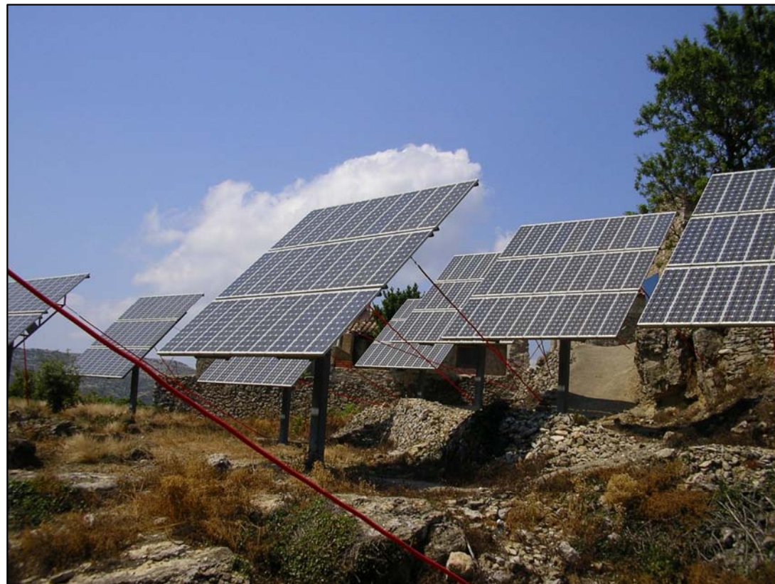
DISPOSICIÓ DEL CAMP FV EXISTENT
