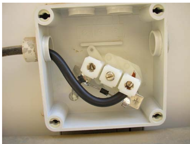
Fotografia 3.16. Detall connexió a terra
