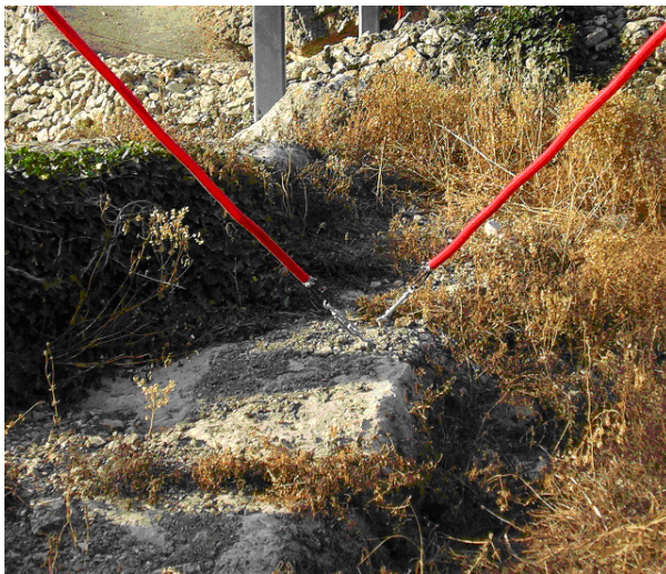
Fotografia 3.11. Detall fixació vents
