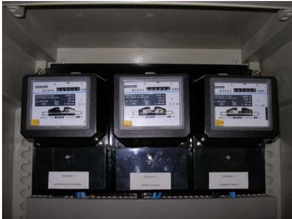
Fotografia 3.9. Comptadors monofàsics existents
