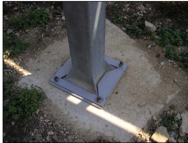
DETALL REFORÇ FIXACIÓ
