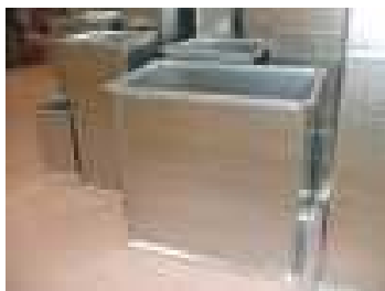
Figura 42. Conduite d'acer galvanitzat per a la ventilació d'aparcaments soterrats
