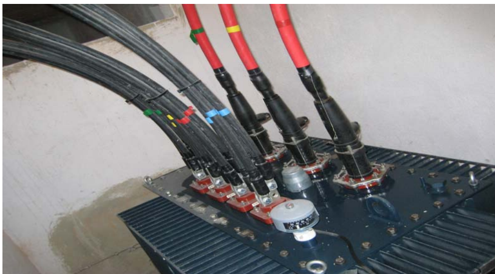
- Figura 9. Puente de MT y de BT -
