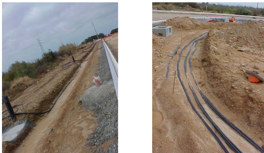
- Figura 13. Tendido de redes de baja tensión -
