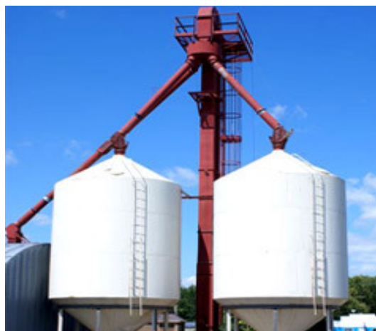
Figura 1. Silos para el almacenaje de harinas
