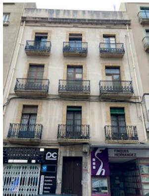
Imagen 4. Fachada del edificio situado en el número 7 de la actual calle Unió.
