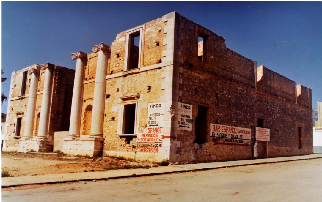
Vista del temple anomenat Església Nova.
