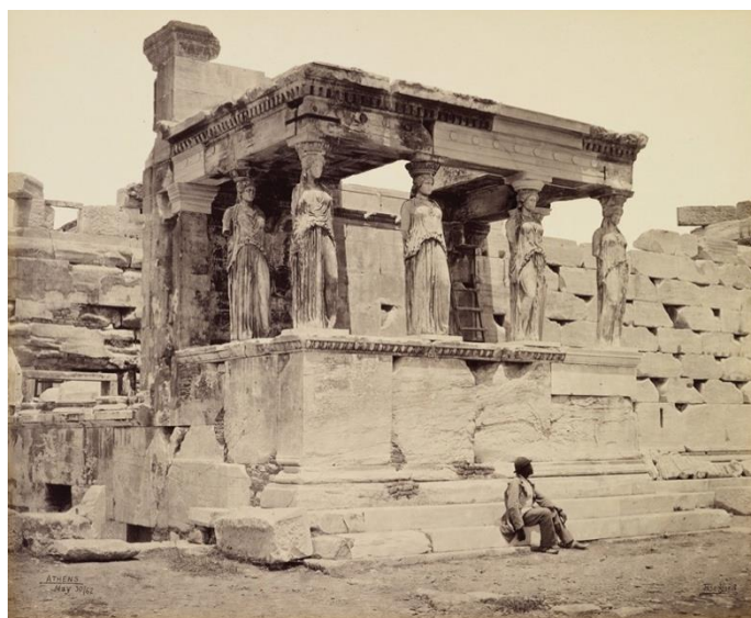
Fig. 146 Vista general del pórtico (S-N). Podemos apreciar la escala humana con respecto a la construcción. Fotografía Bedford, 1862. Royal Collection Trust.
