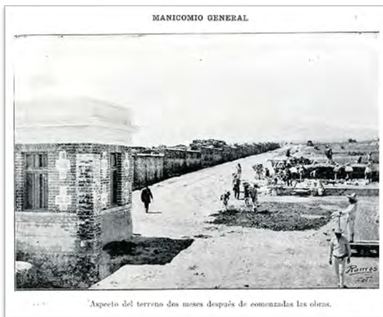
Ilustración 25. Manuel Ramos, Aspecto del terreno dos meses después de iniciadas las obras, 1909.
