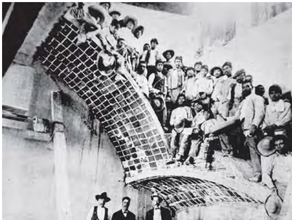
Ilustración 33. Manuel Ramos, Pruebas de resistencia en la bóveda de la escalera del Pabellón de Distinguidos, 1909.
