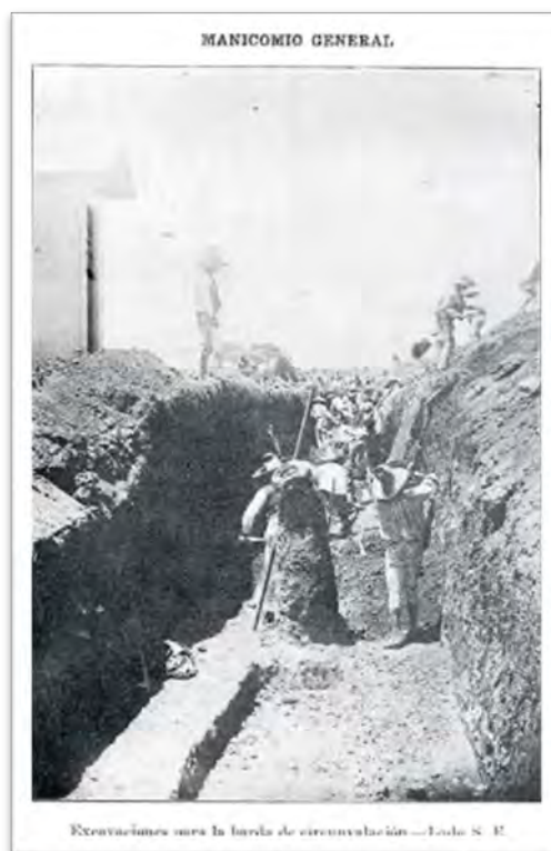
Ilustración 24. Manuel Ramos, Excavaciones para la banda de circunvalación lado S.E., 1909.
