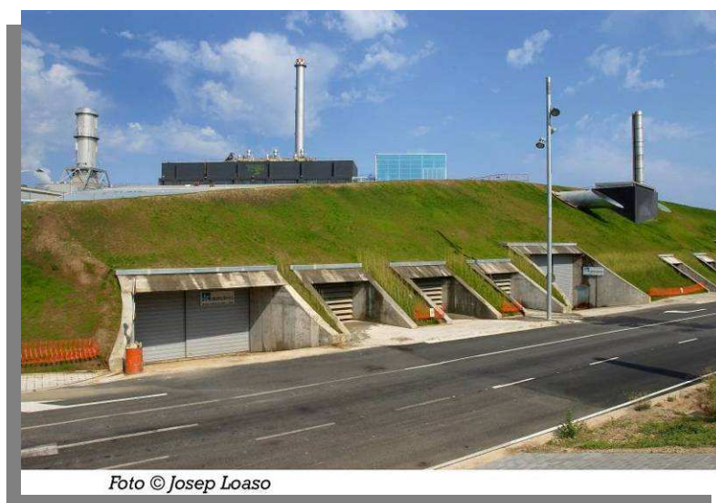
Figura 5-5. Imagen de la central generadora Central Fòrum.
