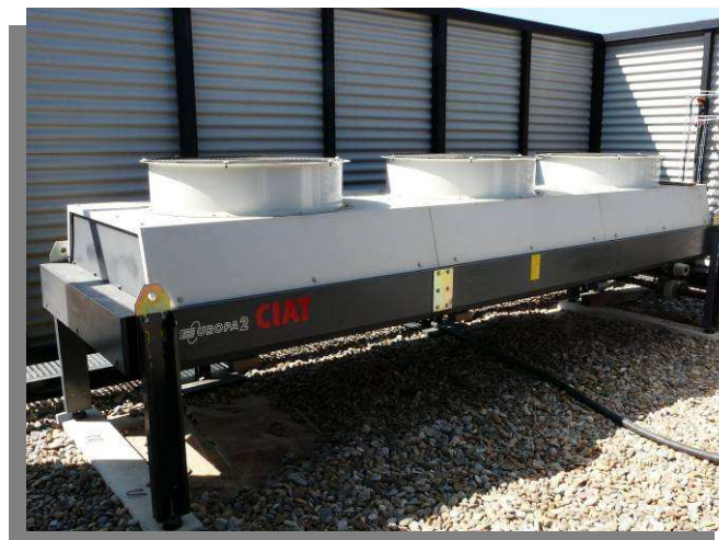
Figura 4-2. Intercambiador de calor aire-agua.
