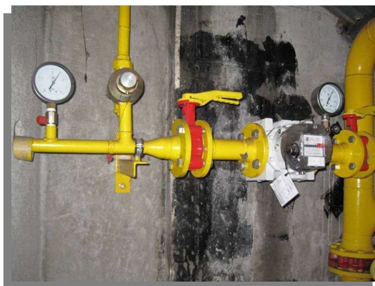
Figura 5-11. Contador de gas natural para la MTG en el edificio Central Fòrum.
