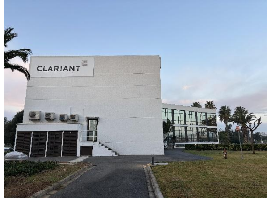
Figura 1. Edifici social del site de Tarragona (Clariant).
