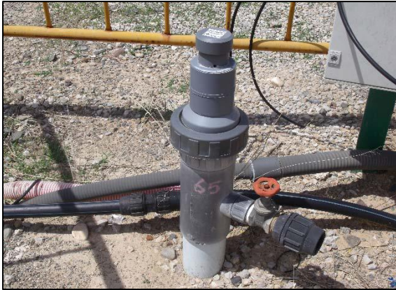
Figura 10: Sistema de Ventilación pasiva visto desde la superficie
