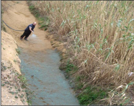
Figura 8: Instalación de la Hidrosiembra
