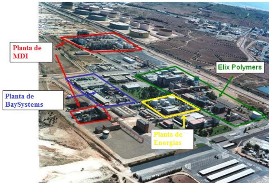
Figura 3.1. Vista aérea de la localización de Bayer MaterialScience S.L.
