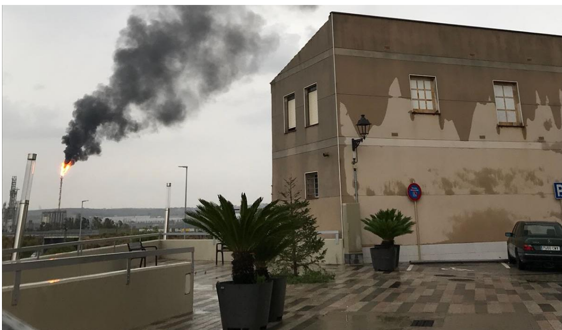
Annex IV: Fotografia d'una situació anòmala en un dia de pluja (bis)
