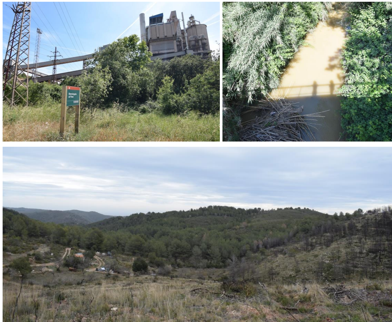
Figura 41. Impactes presents en diversos espais naturals protegits: la cimitera Uniland a una entrada del parc del Foix, on el riu Foix es troba en mal estat (a dalt) i Massís de Bonastre cremat (a baix).
