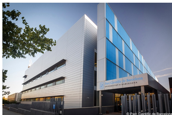
Figura 1. Roser, Q., 2018. Imatge de l'edifici principal del Parc Científic de Barcelona [fotografia]. FONT: Parc Científic de Barcelona.
