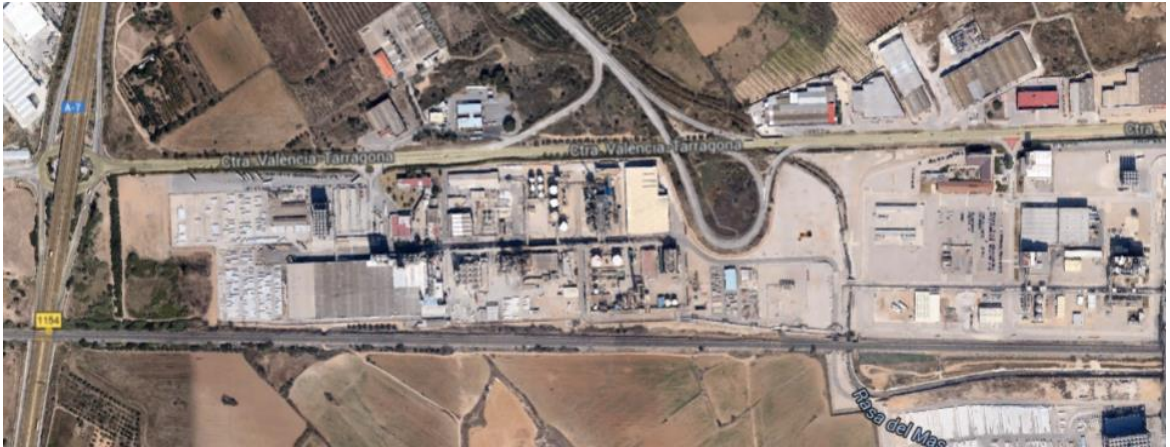
Figura 6.1. Vista aérea de las instalaciones del subpolígono TAQSA.
