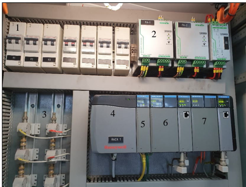
Figura 4.3. Módulos del armario de Honeywell .
