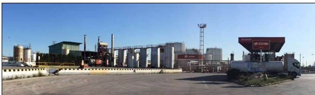
Figura 3.1. Fotografía de la planta de Asfaltos CCP Tarragona actual.
