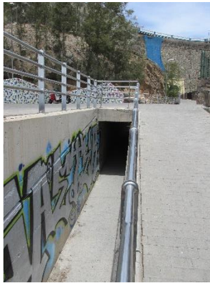
Figura 59. Canalització d'aigües a Patalavaca-Arguineguín.
