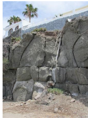
Figura 60. Canalització d'aigües a Patalavaca-Arguineguín.
