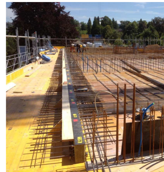
sistema de consola aislante, puesta en obra
