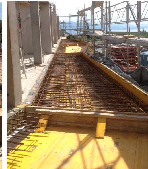
sistema de consola aislante, puesta en obra
