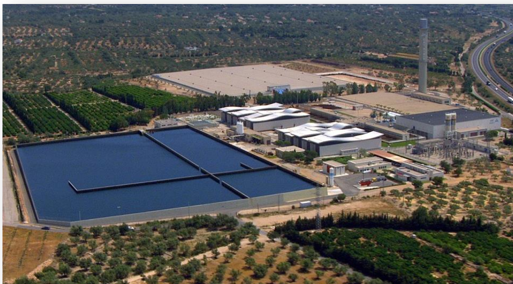
Figura 2. Instal·lacions del CAT a l'Ampolla.
