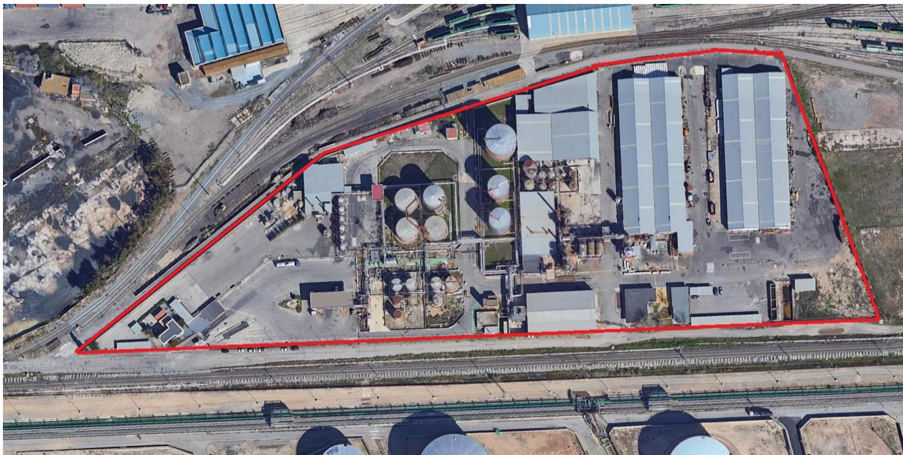
Figura 4.1. Vista aérea de la planta. Límites marcados en rojo. (ref. 4.).
