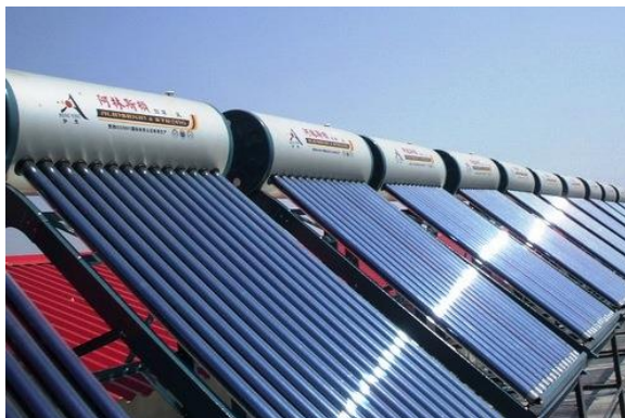
Ilustración 11. Placas solares térmicas en edificio industrial
