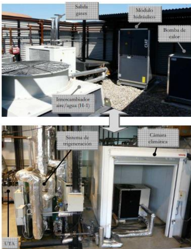
Ilustración 63. Sistema de trigeneración integrado en el CREVER - URV.
