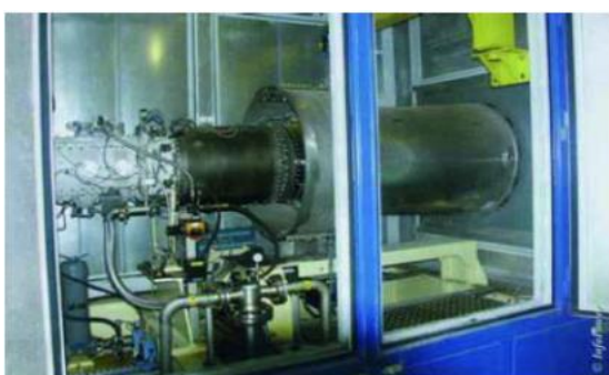
Ilustración 5. Turbina de gas de 4,6 MW. Leche Pascual Ilustración 6. Turbina de gas de 3,8 MW. Papelera del Oria.
