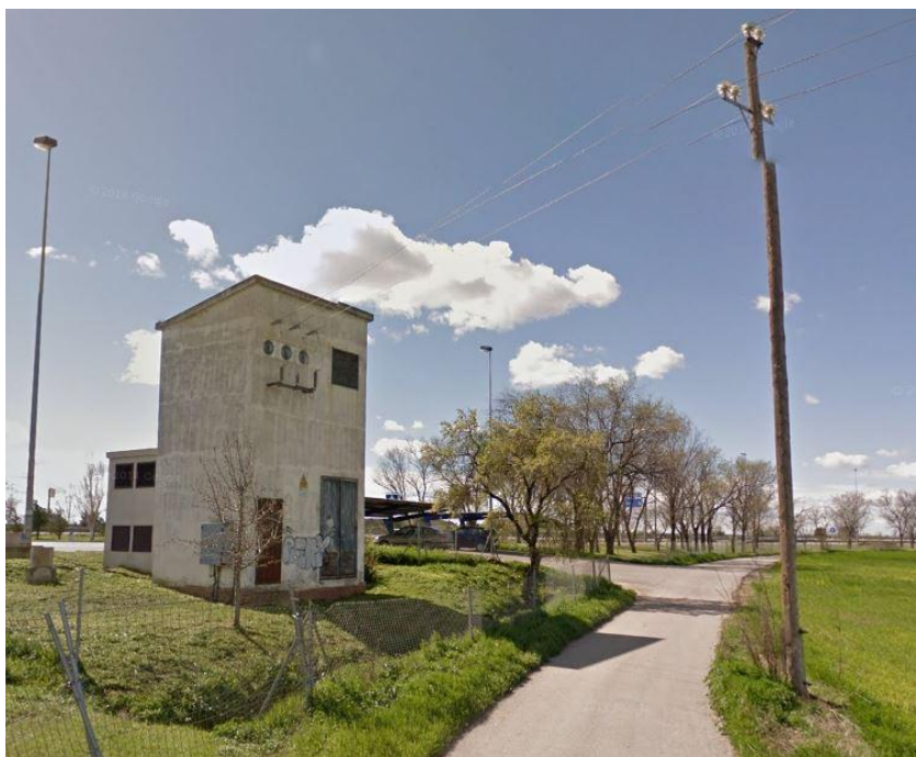
Figura 17. Subministre d'energia elèctrica electrolinera
