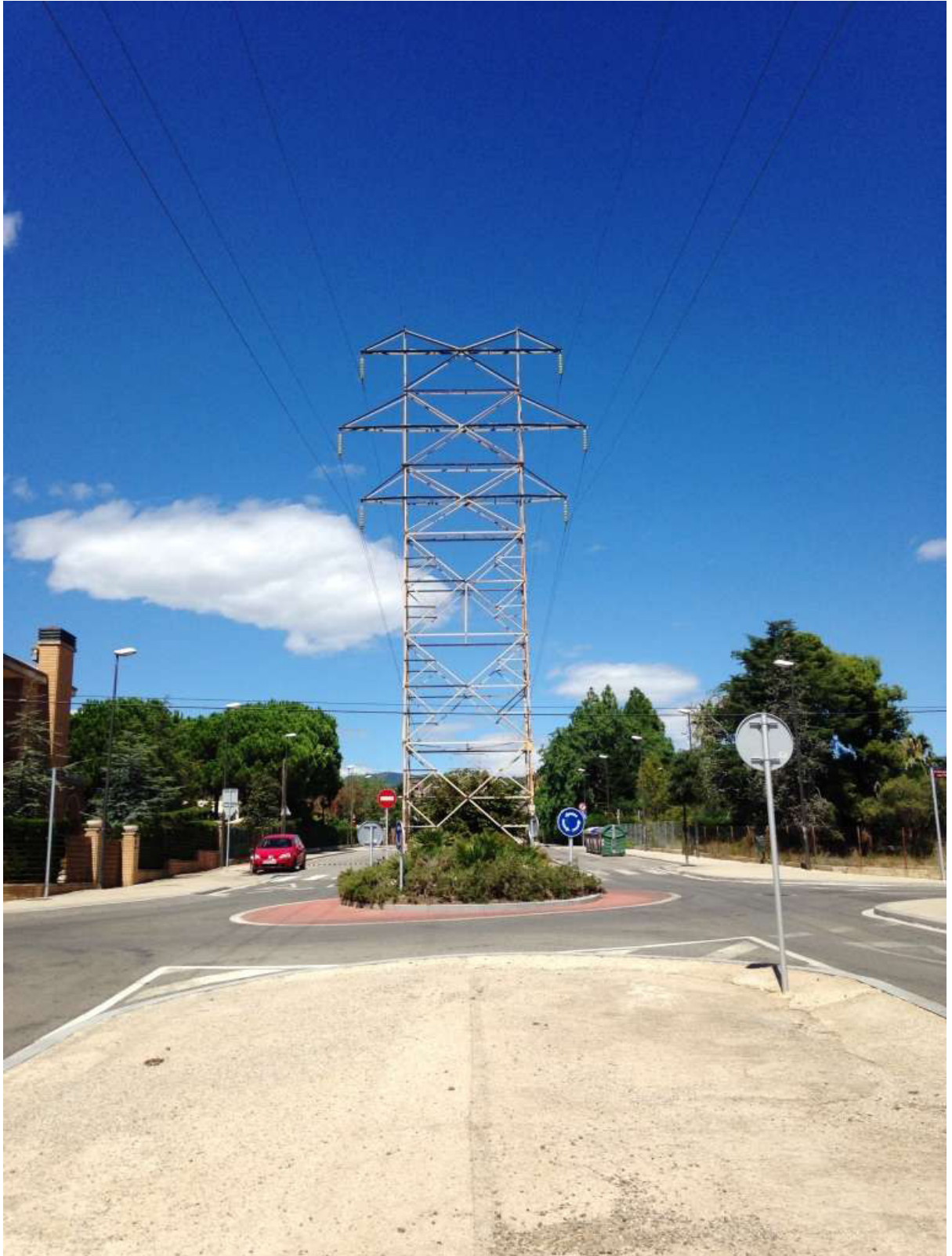
Fig 8: Torre d'alta tensió línia Reus - Serós de l'Avinguda de les Torres al terme municipal de Reus pròxima a l'Avinguda dels Pins.
