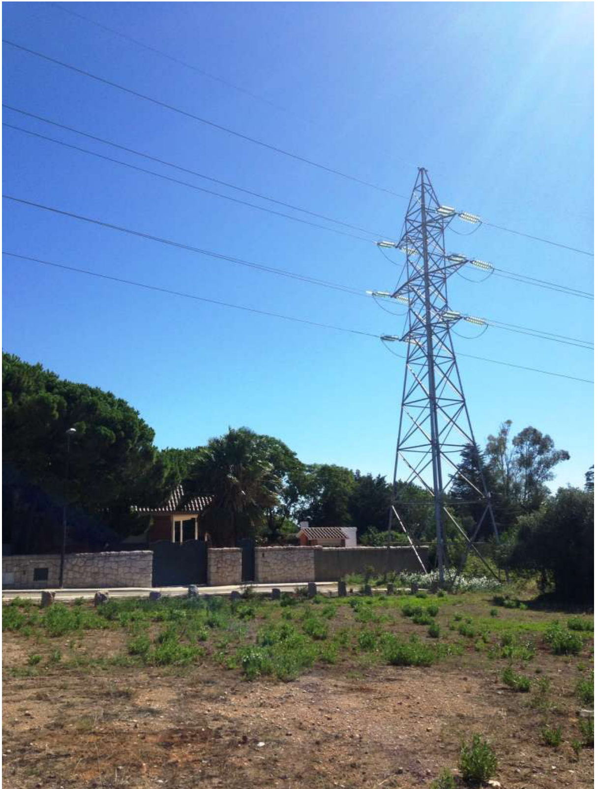
Fig 4: Torre d'alta tensió línia Reus - Ascó del C/Montsià pròxima a C/Conflent i camp de futbol.
